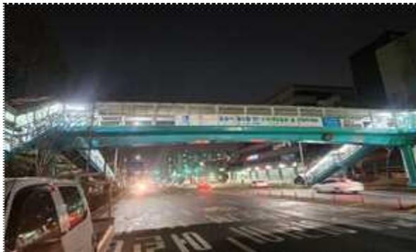
▶ 육교 현판 설치
