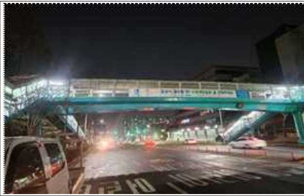
▶ 육교 현판 설치
